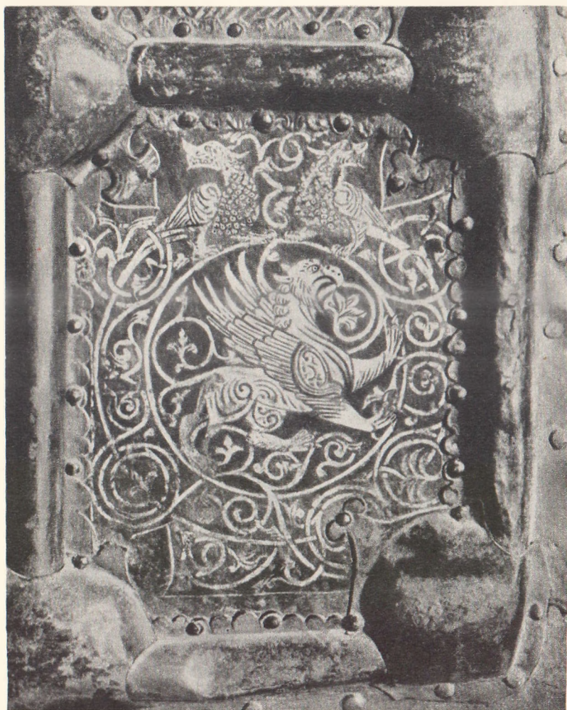
В сложной технике золотой наводки по меди выполнен тонкий рисунок южных врат собора в Суздале. Медную пластину покрывали лаком, процарапывали рисунок и протравливали кислотой. Затем наносили амальгаму золота в ртути и нагревали пластину. Ртуть испарялась, а тонкий слой золота плотно приставал к протравленным местам.
